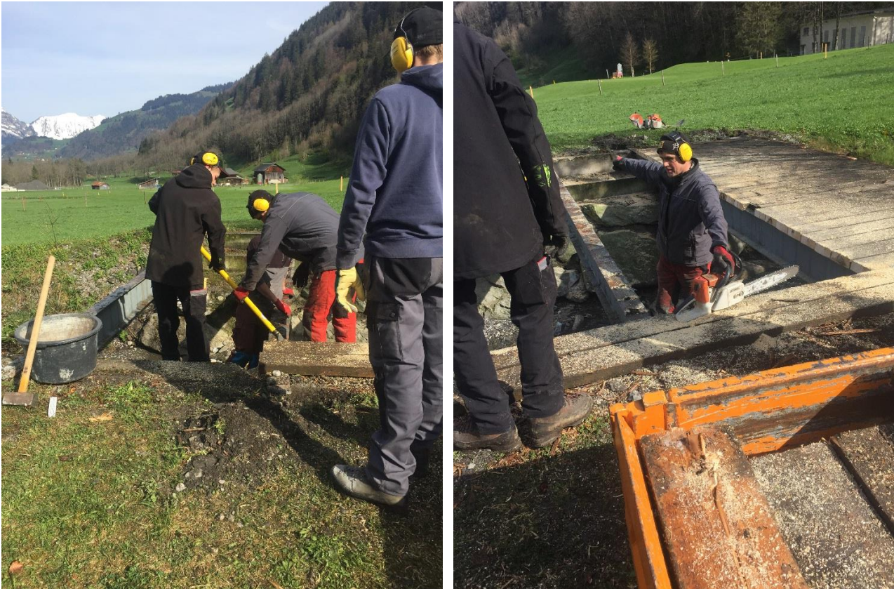
Beim Restaurant Wasserfall entsteht eine neue Brücke (Foto: Joao C.)
